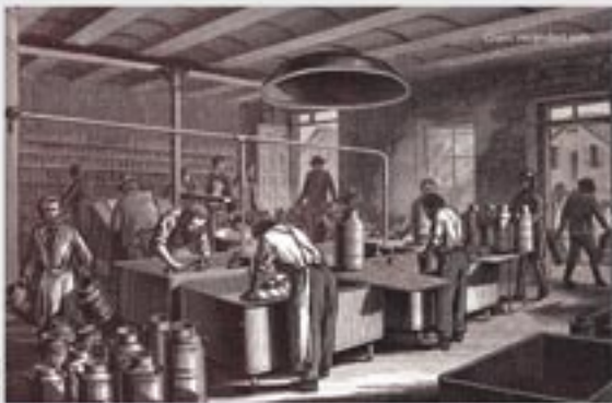
Taglich kamen unzählige Milchkannen hier in die Anlaufhalle der Kondensmilchproduktion.
